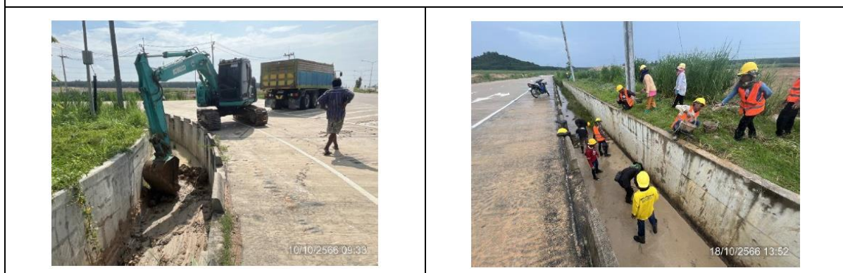
(5) การขุดลอกรางระบายน้ำฝนของโครงการ
